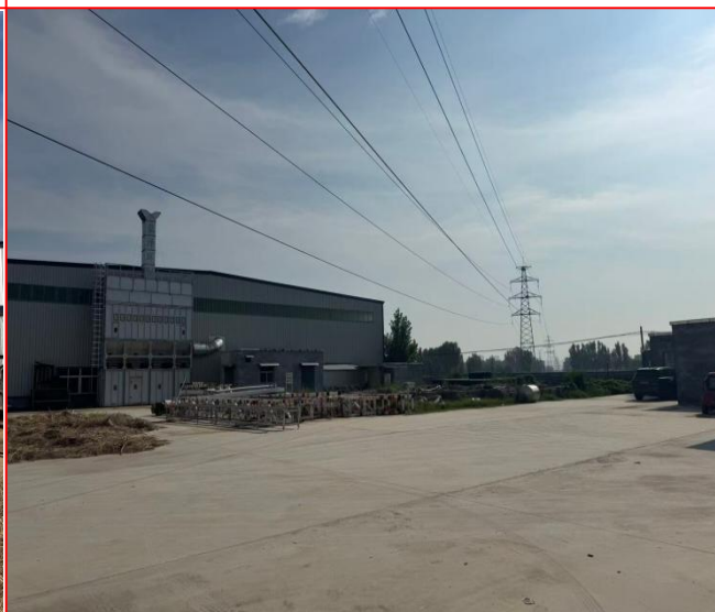
北侧高压线及新乡市爱源家具有限公司
